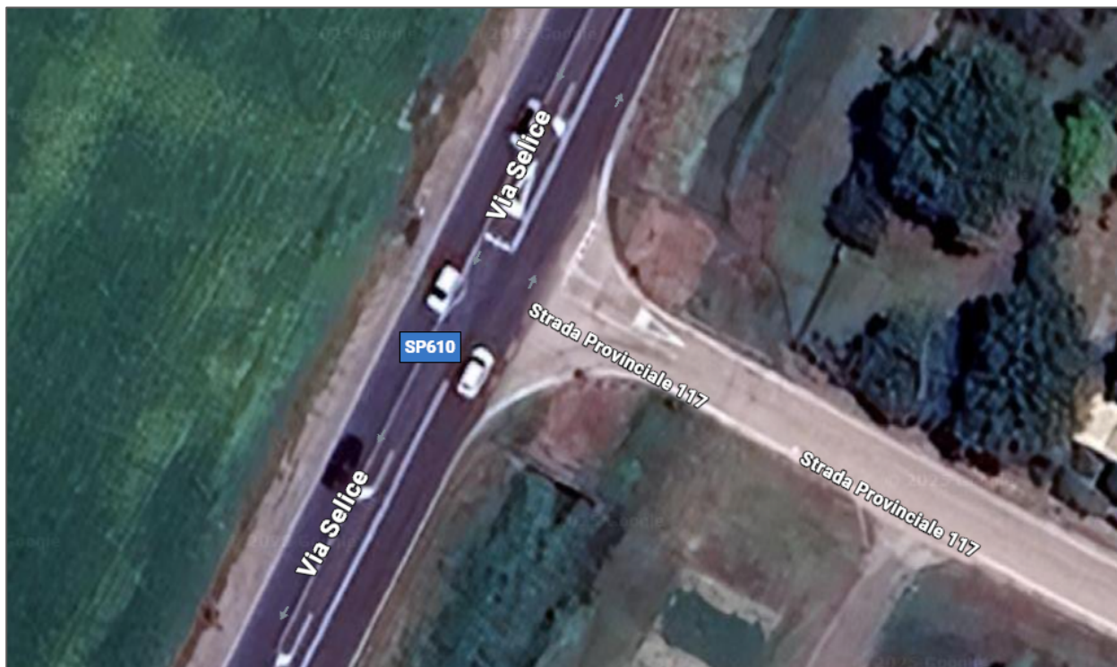
Figura 3 – Dettaglio dell'innesto della S.P.117 Palmiera sulla SP610 Selice (fonte: Google Maps)
