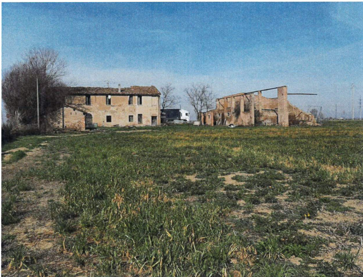
Foto immobili da demolire
