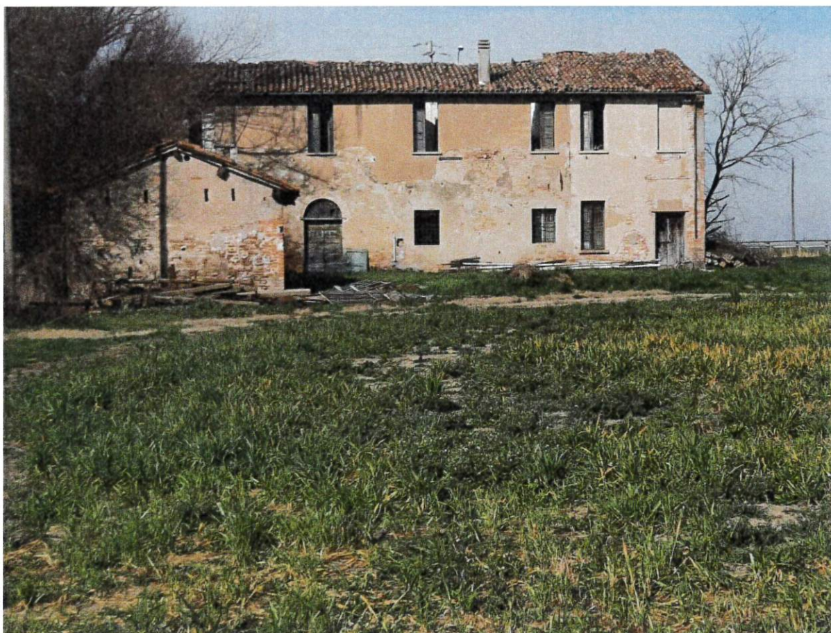
Foto immobili da demolire
