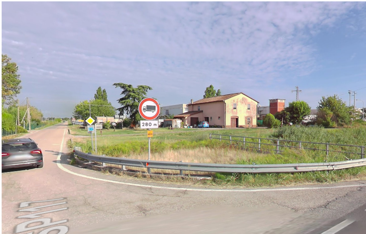
P.Km 0+000 – Lato oggetto di adeguamento - Barriera di sicurezza da rimuovere
