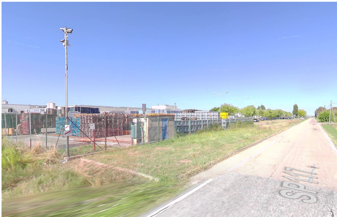
P.Km 0+350 – Lato oggetto di adeguamento – Tratto escluso dalla stabilizzazione a calce
