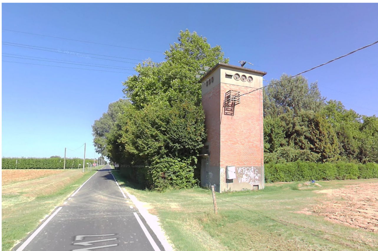
Cabina ENEL esistente
