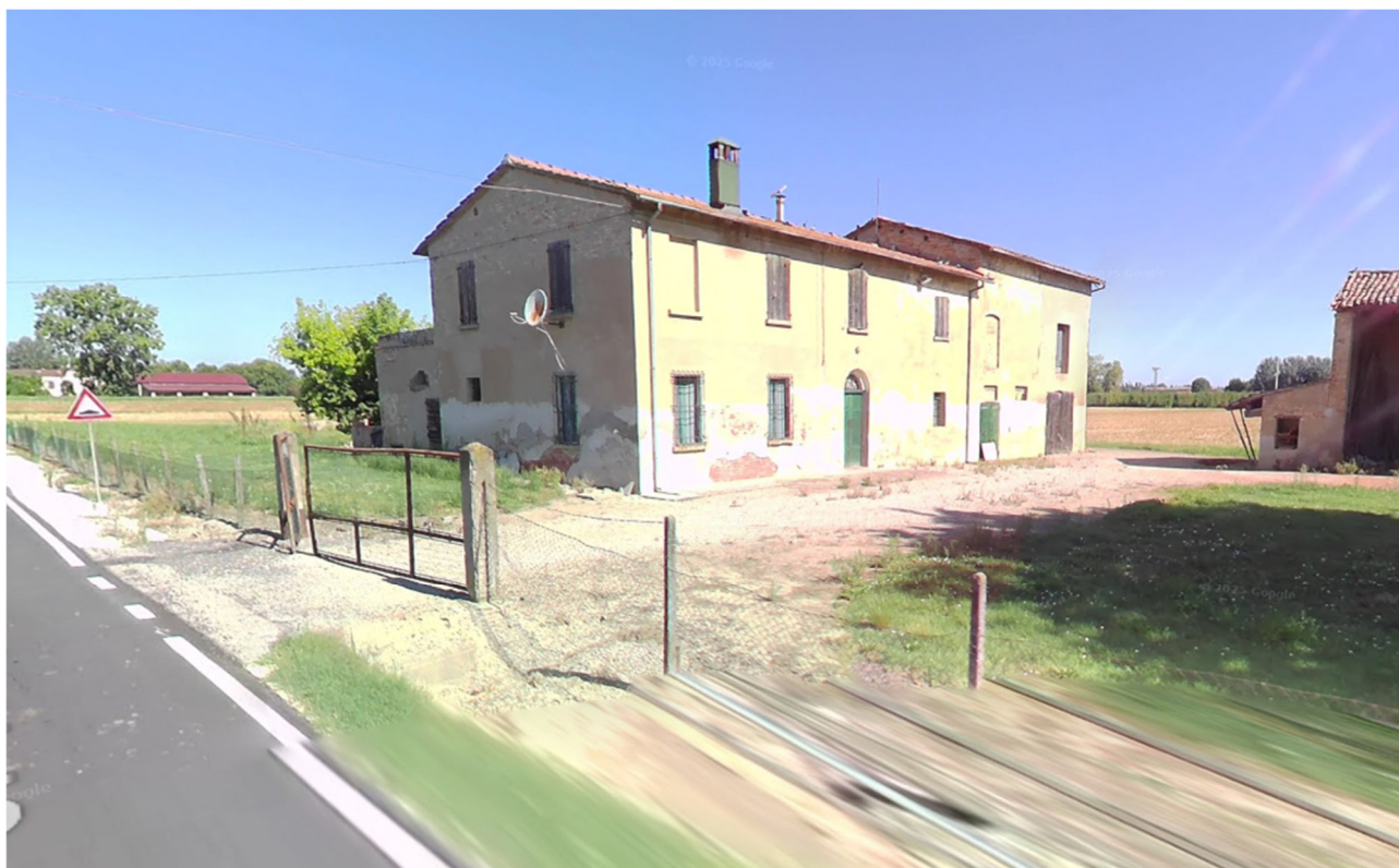
Casolare vicino p.km 3+000
