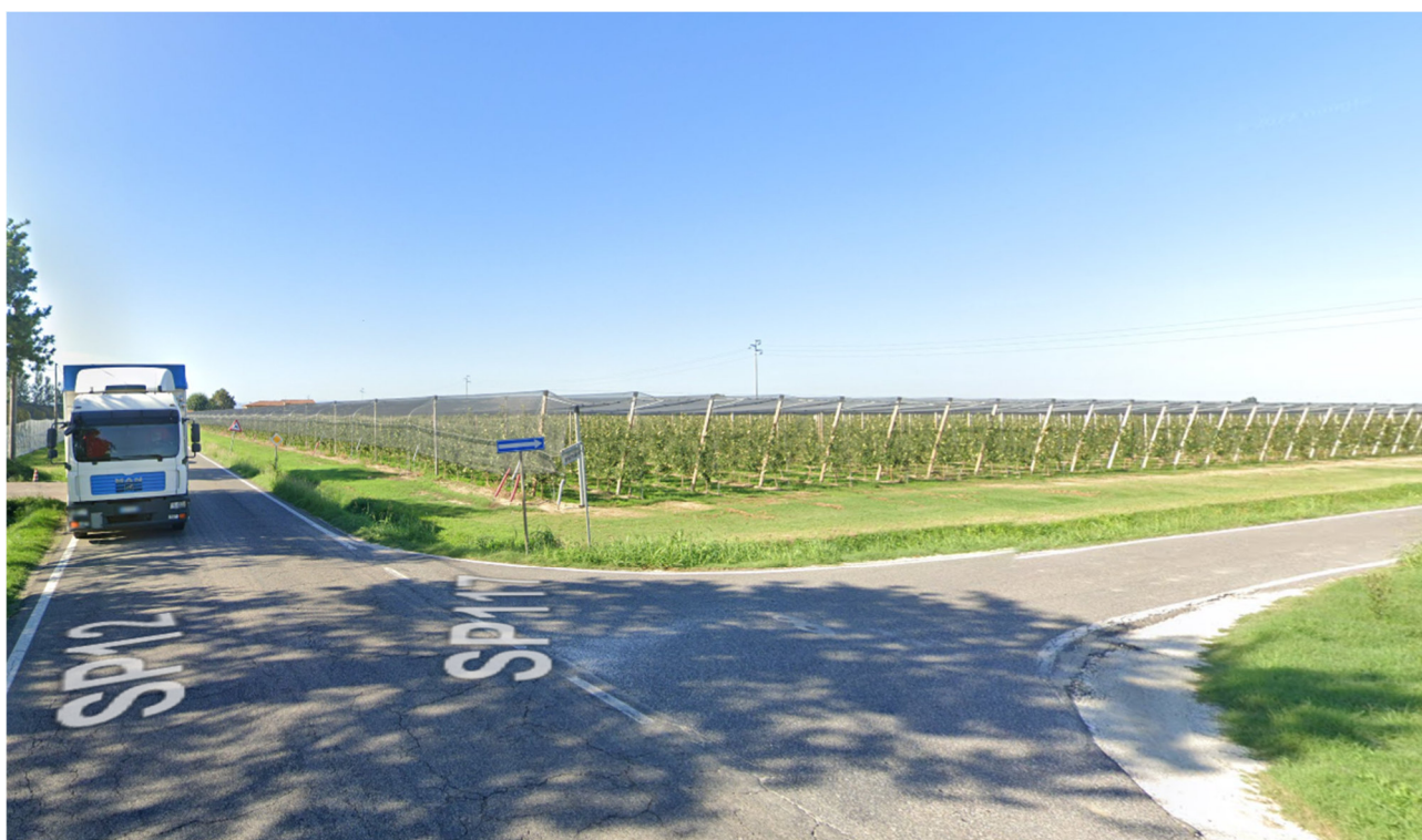
P.Km 3+935 – Fine intervento
