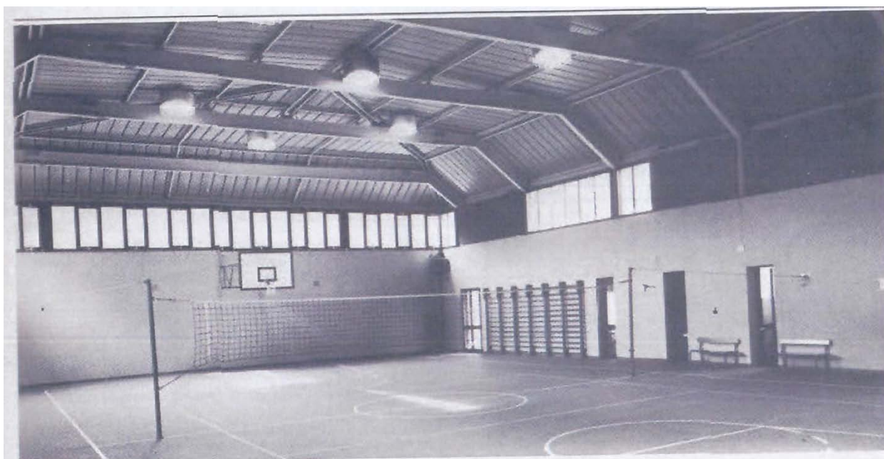
Fig. 6. La sala superiore: vista della carpenteria e della copertura.
