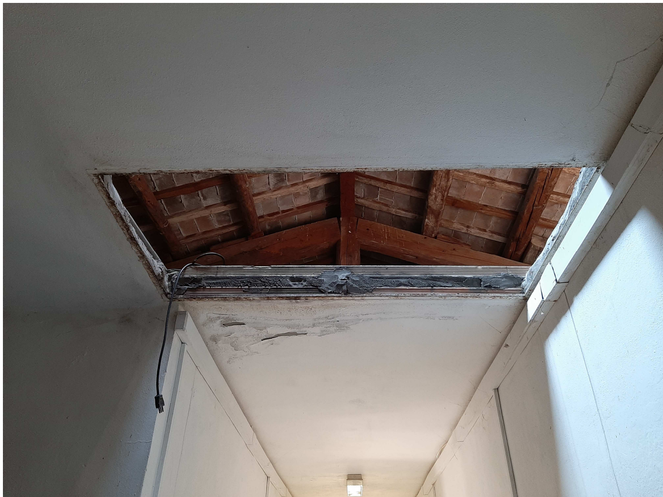
12 ) particolare solaio di copertura con capriate in legno impalcato di tavelle e manto in coppi Soffitto in tavelloni intonacati
