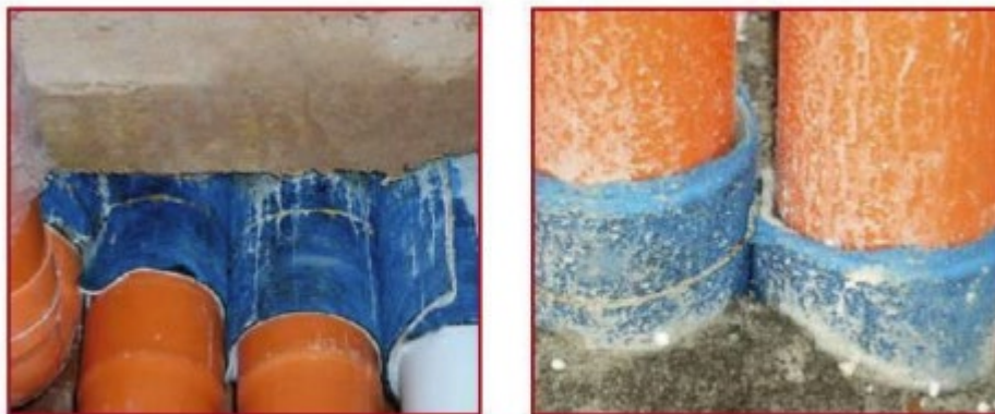
Fig 11 - particolare di tubi ricoperti con guaine isolanti al passaggio di muri e solette.
