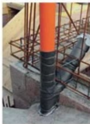
Fig 13b - particolare per l'isolamento dei tubi
