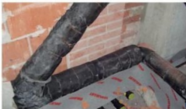
Fig 13a - particolare per l'isolamento dei tubi
