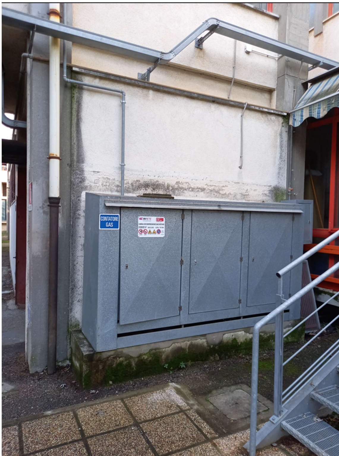
Contatori gas metano, installati in nicchia esterna adiacente alla sottocentrale esistente
