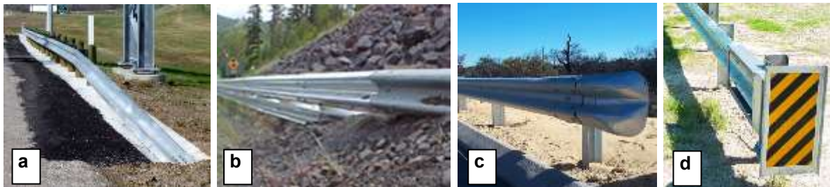
Fig. 4 – Tipologie dei terminali di barriera
