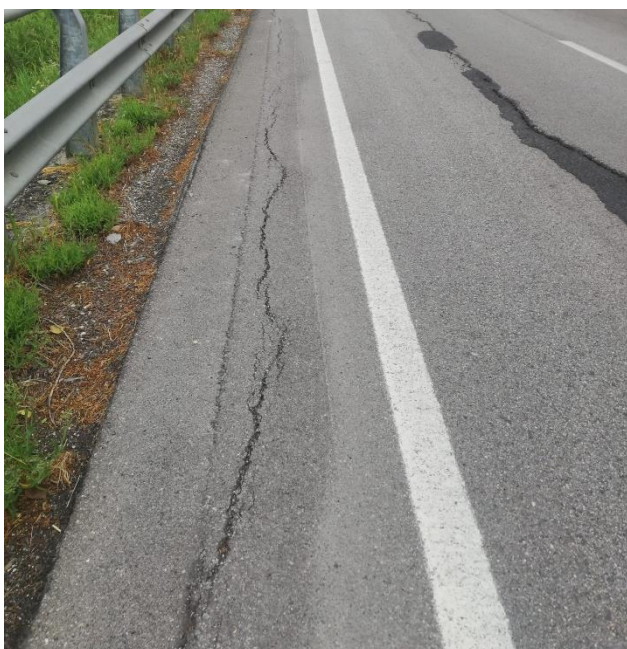
Figura 2 – Esempio di fessurazioni longitudinali
