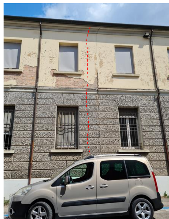
Figura 22 Corpo A: lesione verticale su prospetto via Cortesi in corrispondenza di pilastro in c.a.
