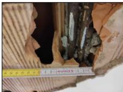
Figura 31 Saggi visivi solai per individuazione struttura
