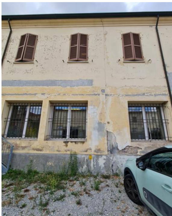
Figura 21 Corpo A: lesione verticale su prospetto cortile interno in corrispondenza di pilastro in c.a.
