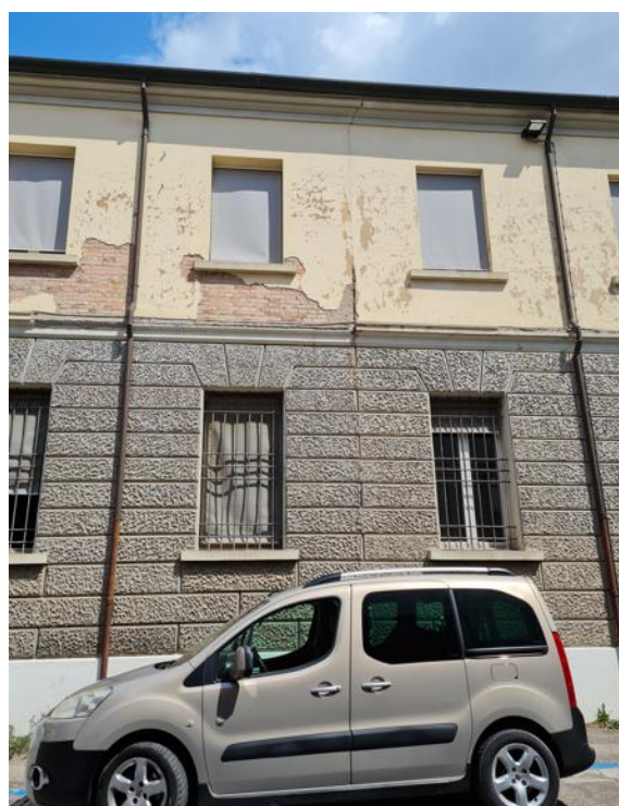
Figura 22 Corpo A: lesione verticale su prospetto via Cortesi in corrispondenza di pilastro in c.a.
