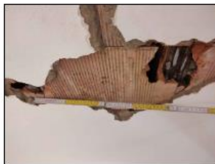
Figura 31 Saggi visivi solai per individuazione struttura
