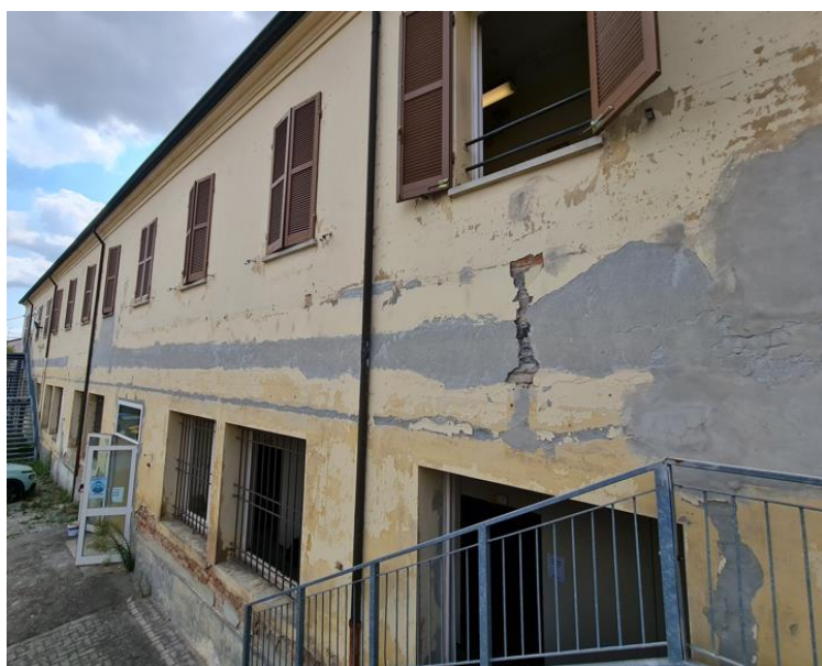
Figura 19 Cordolo di piano Corpo A primo impalcato
