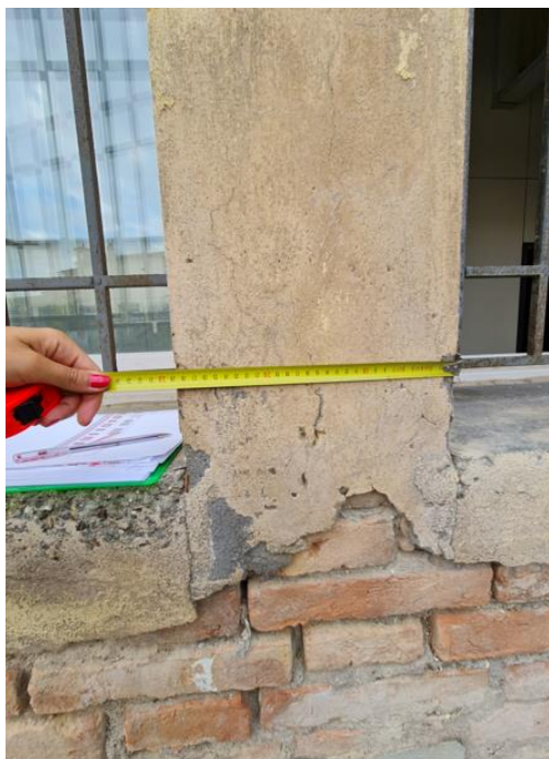
Figura 20 Pilastrini snelli in muratura corpo A
