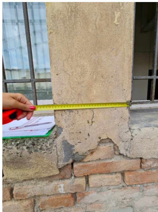
Pilastrini in muratura lesionati Corpo A dal cortile interno
