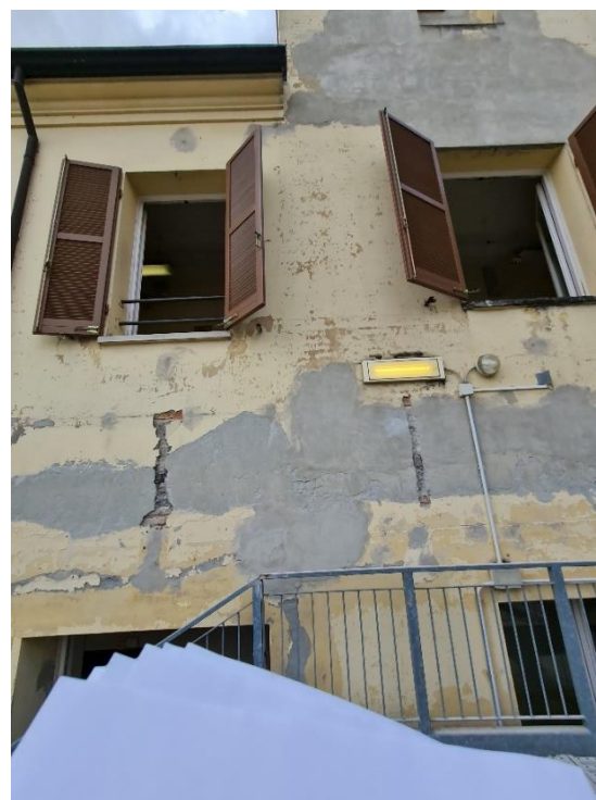
Distacchi dell'intonaco Corpo A dal cortile interno
