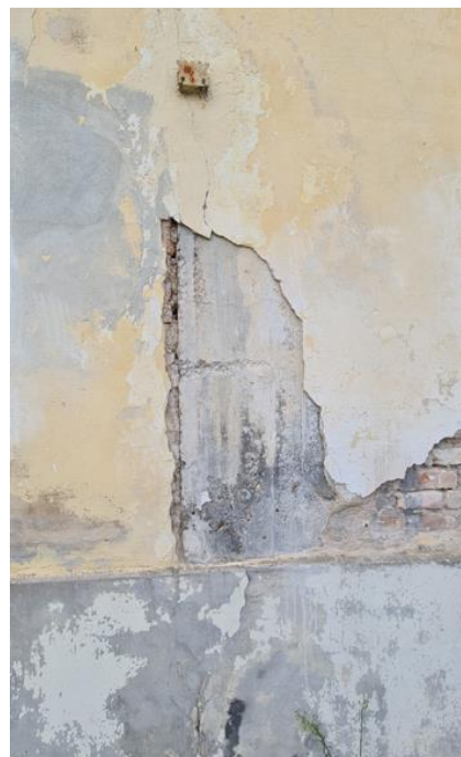
Figura 19 Cordolo di piano Corpo A primo impalcato
