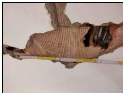
Figura 31 Saggi visivi solai per individuazione struttura
