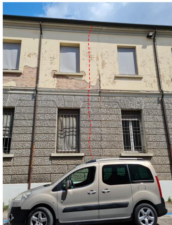
Figura 9 Corpo A: lesione verticale su prospetto via Cortesi in corrispondenza di pilastro in c.a.
