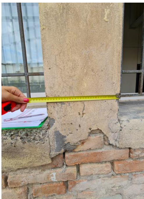
Figura 7 Pilastrini snelli in muratura corpo A
