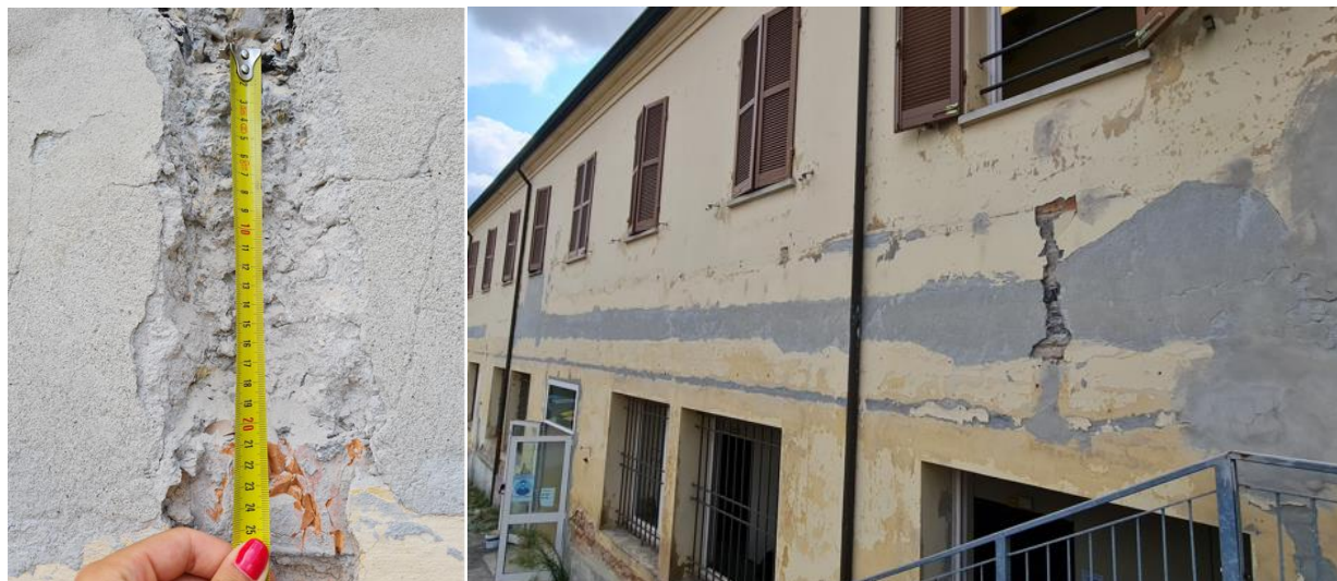
Figura 25 Cordolo di piano corpo A
