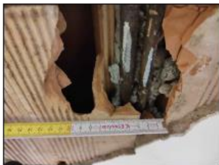
Figura 18 Saggi visivi solai per individuazione struttura
