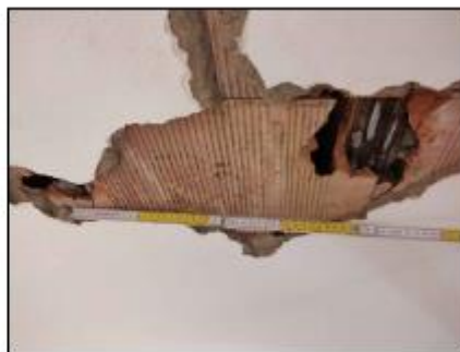
Figura 18 Saggi visivi solai per individuazione struttura
