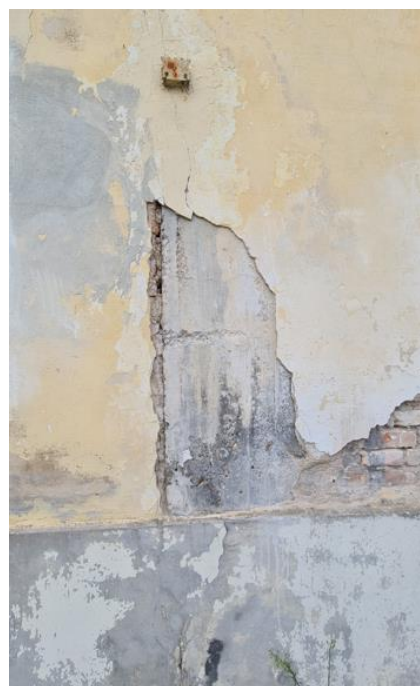
Figura 6 Cordolo di piano Corpo A primo impalcato
