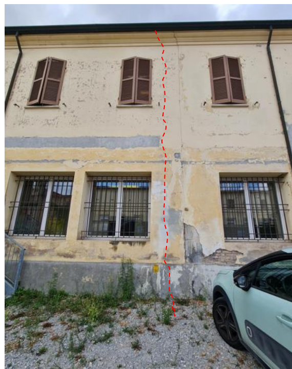
Figura 8 Corpo A: lesione verticale su prospetto cortile interno in corrispondenza di pilastro in c.a.
