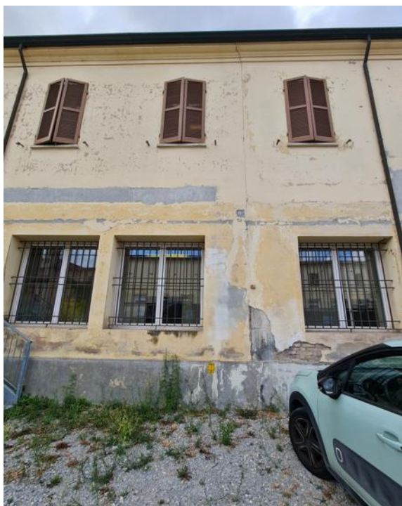
Figura 8 Corpo A: lesione verticale su prospetto cortile interno in corrispondenza di pilastro in c.a.
