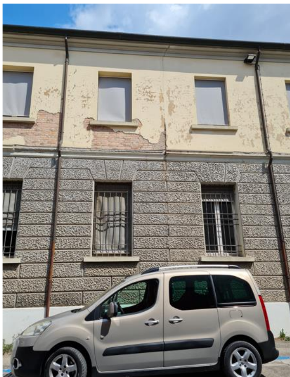
Figura 9 Corpo A: lesione verticale su prospetto via Cortesi in corrispondenza di pilastro in c.a.
