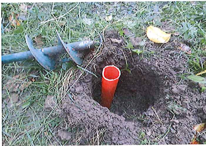
Foto 1 - Preforo a distruzione e rivestimento in pvc.
