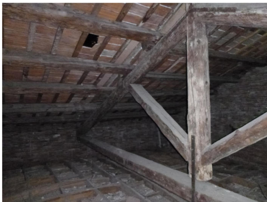
Figura 14: particolare di una zona della copertura con presenza di alcuni tavelloni rotti
