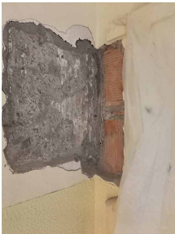
Saggio incrocio pareti ingresso via delle ceramiche (Corpo A)
