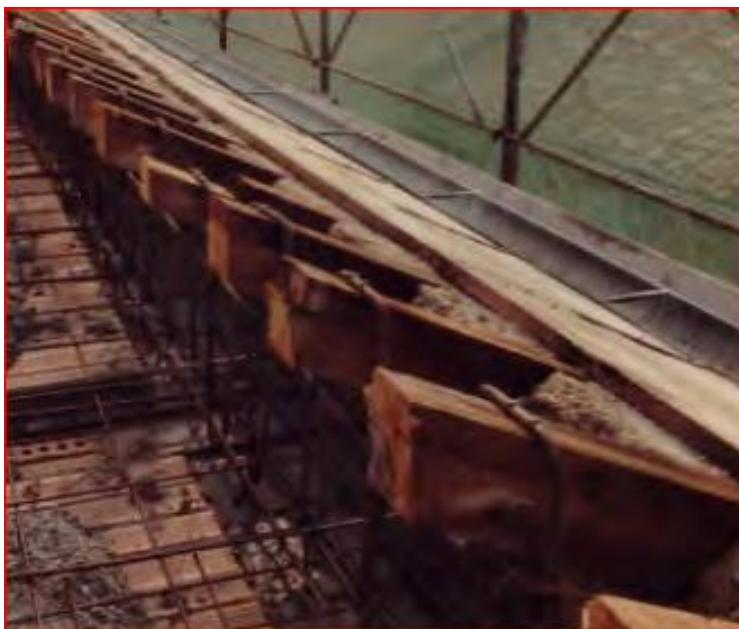
Cordolo su Via T. dall'Ova con ancoraggio del cornicione foto cantiere anni ottanta
