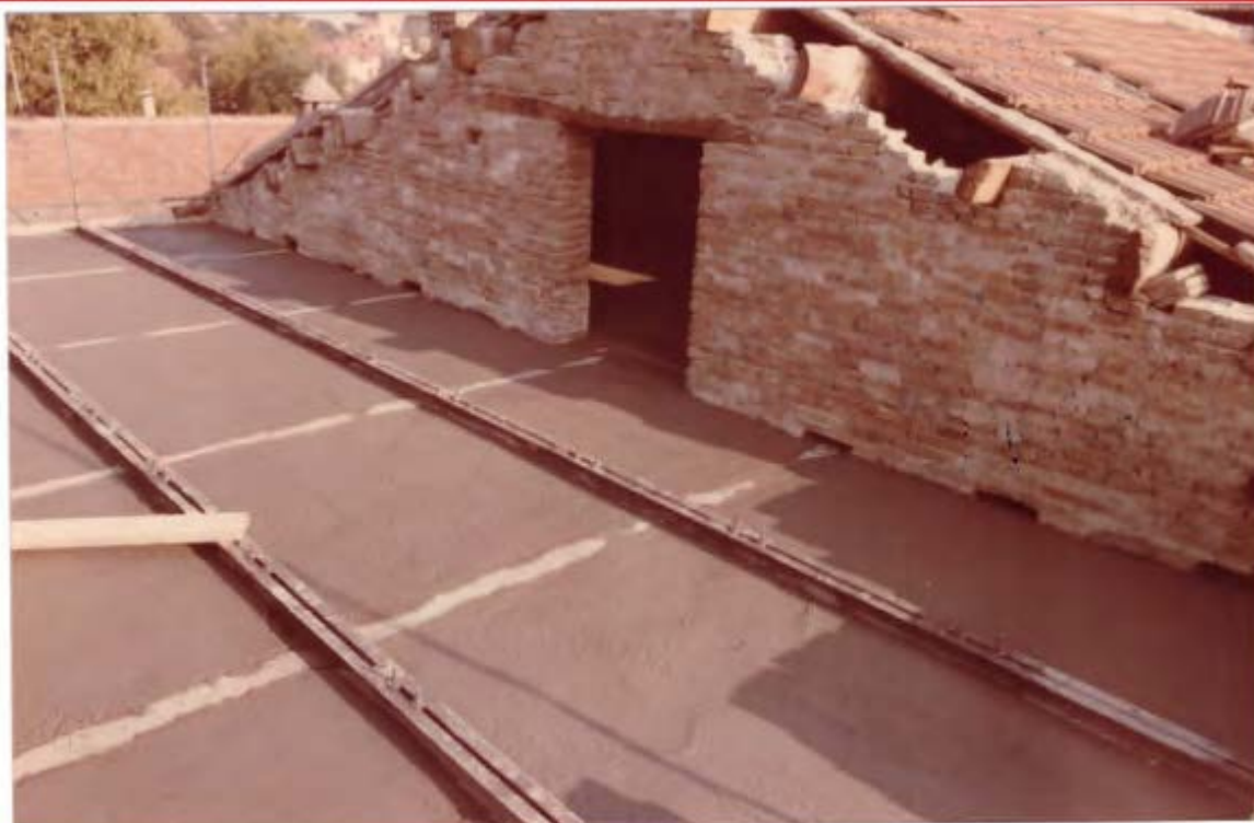
Doppi Upn di sospensione (il coperto ligneo è stato poi completamente sostituito)
