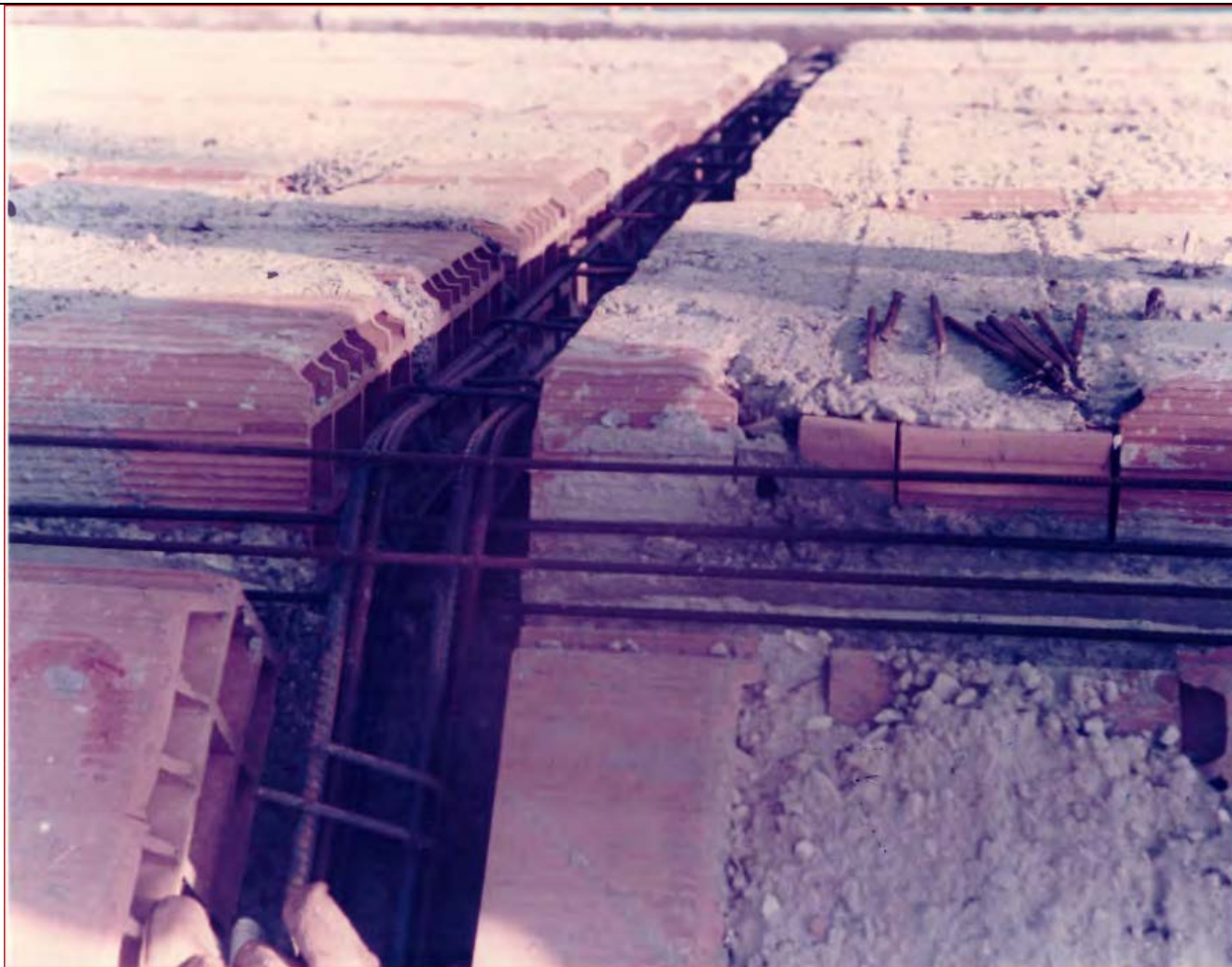
Cordolo di colmo e cordolo sopra alla parete trasversale su Via Guaccimanni
